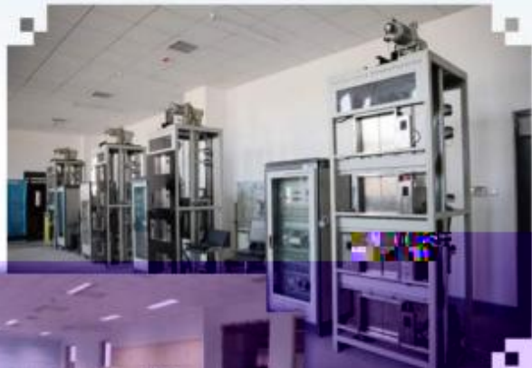
智能电梯安装调试 维护训练场所
